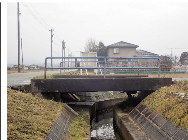
RC短支間橋の例 橋長4.8m、幅員6.6m
